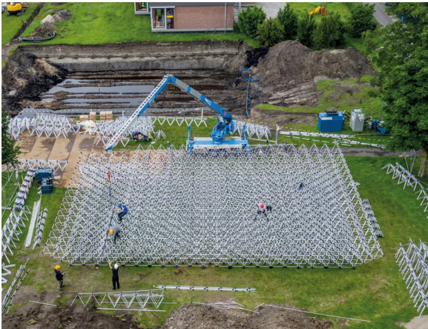
Figuur 6: Spaceframe tijdens de constructie en voordat het in het gat werd gehesen.
