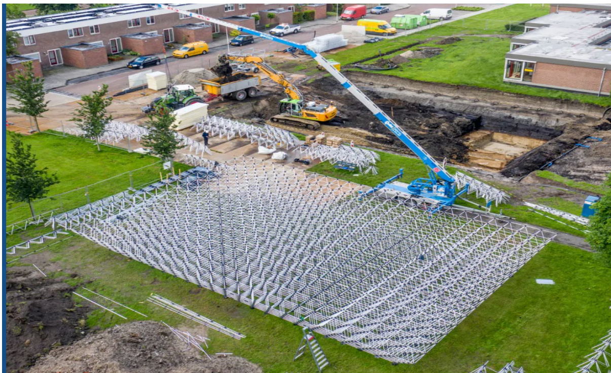
Fig. 6 Impressiefoto van het bijna gereed gestelde aluminium spaceframe
