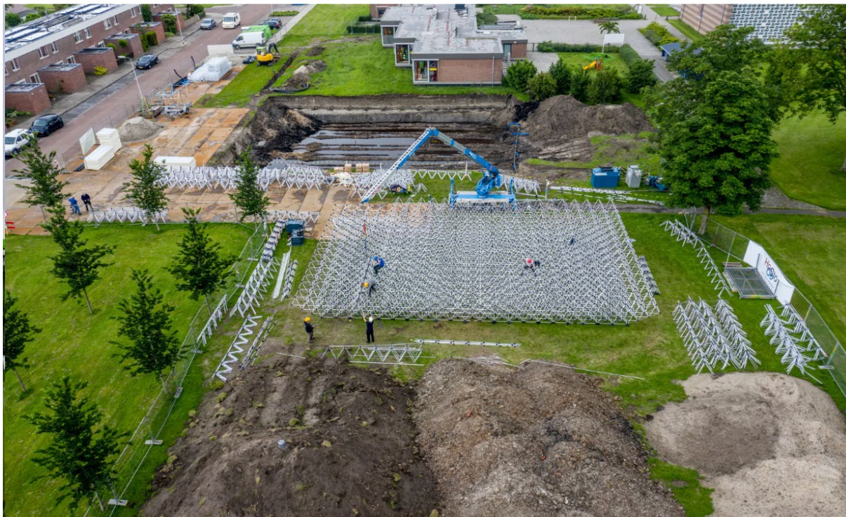
Fig. 4 Afgraven waterbuffer en assemblage 'Hocosto spaceframe' (eerste generatie)
