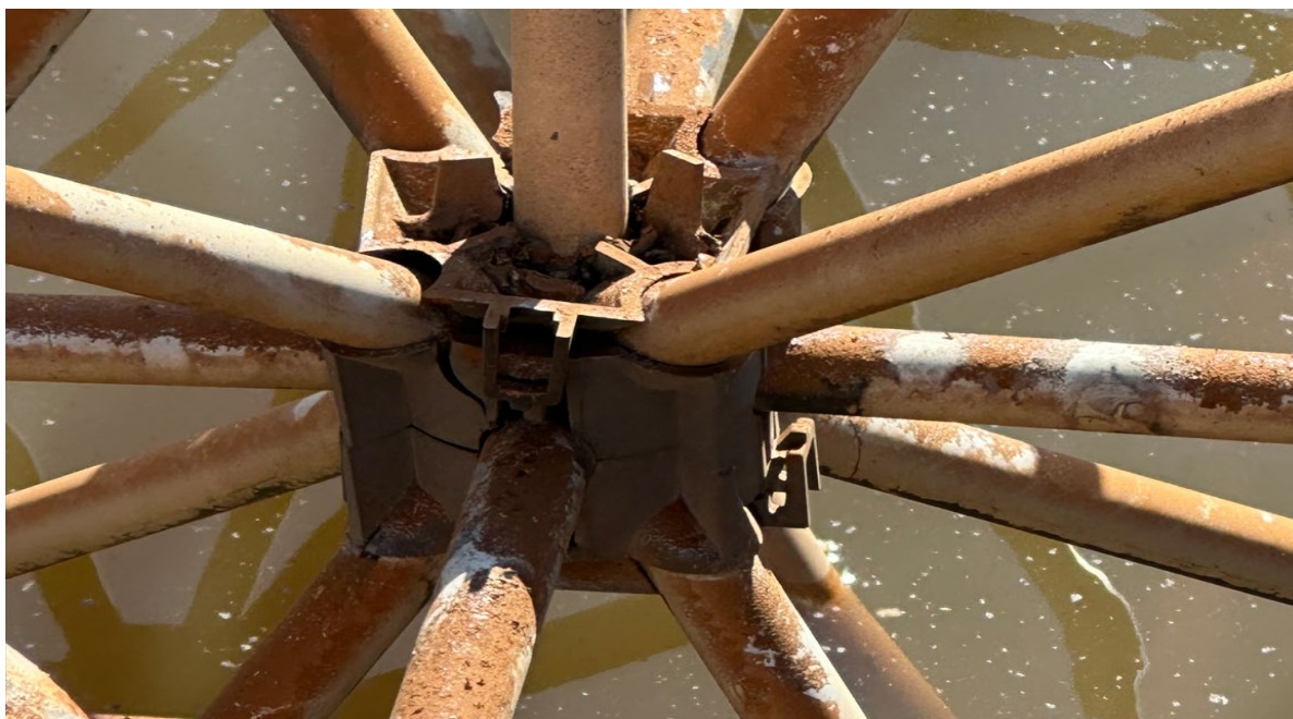
Fig. 10 Polyamide koppeling (node) spaceframe en roestafzetting van de metalen buitenmantel van de dekplaten
