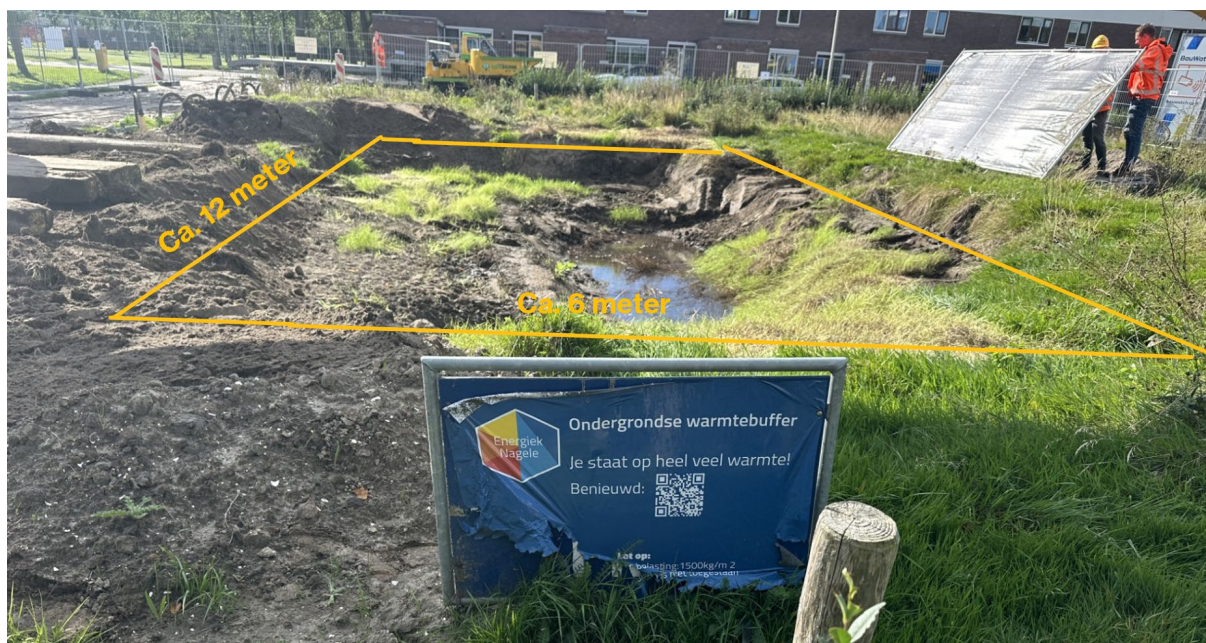
Fig. 7 Foto-opname van 2 september 2025. De verzakking aan de bovenzijde van de Hocosto waterbuffer die op 18 augustus 2025 werd aangetroffen bleek inmiddels groter te zijn geworden, ca 12 x 6 m
