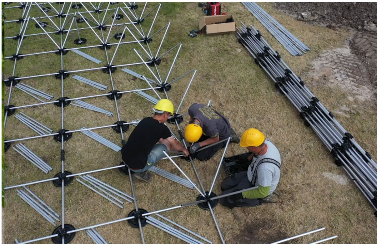
Fig. 5 Assemblage bodemgedeelte van het aluminium buizen-spaceframe met voetplaten van glasvezelversterkte polyamide PA66
